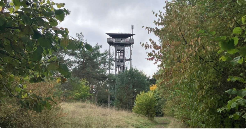
Wegen Einsturzgefahr gesperrt
