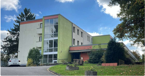
Haus Roßberg in Montabaur
