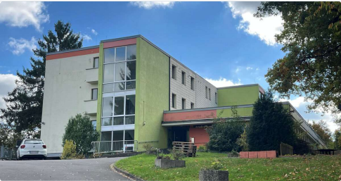
Haus Roßberg in Montabaur
