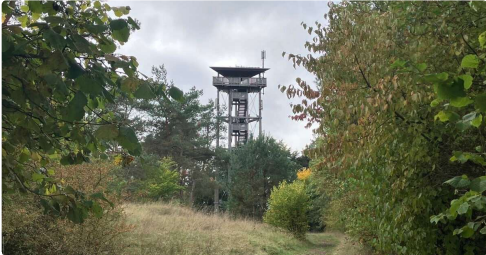
Wegen Einsturzgefahr gesperrt
