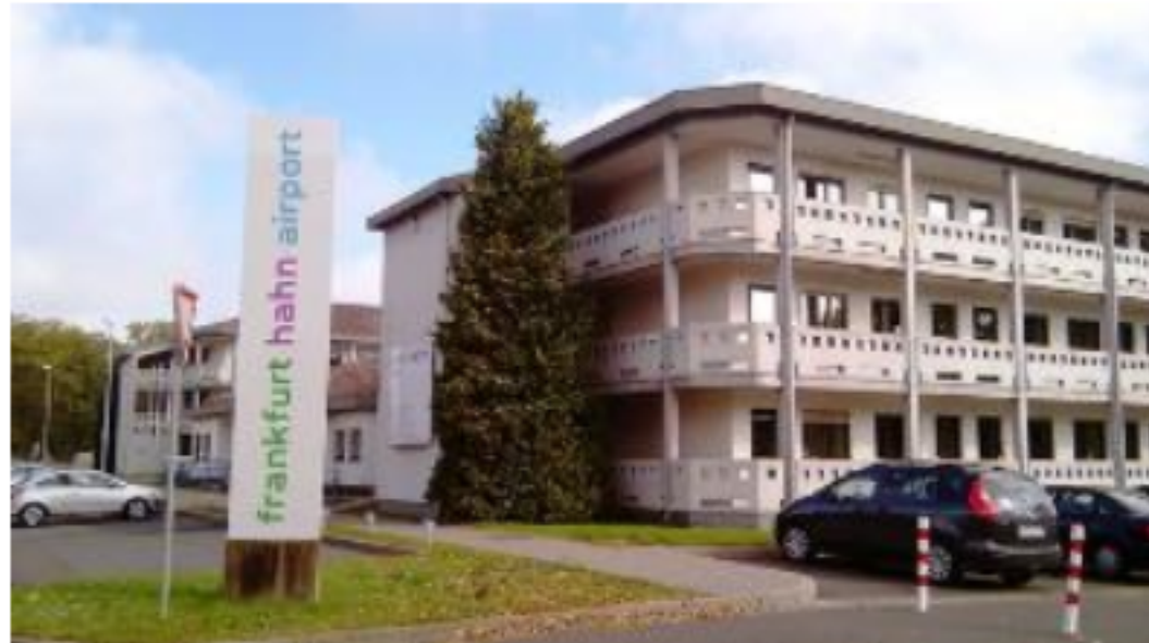
Ein Verwaltungsgebäude auf dem Gelände des Flughafens Hahn
